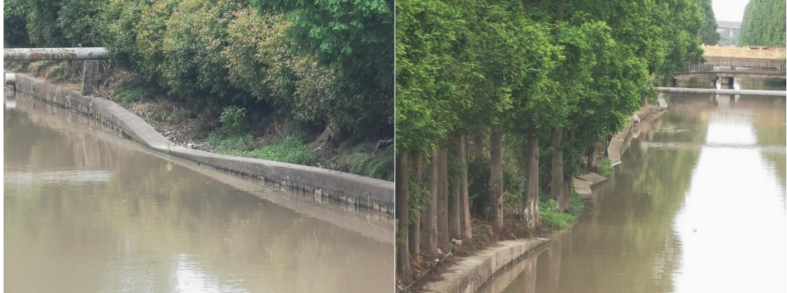
图 5.4-1 东横圩现状照片（无名桥—七甲港）
