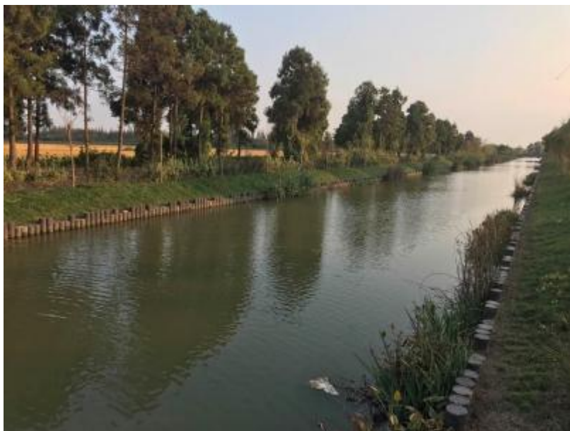
图 7.3-2 仿木桩护岸实景图
