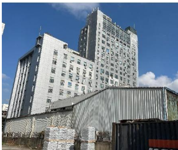
项目厂区南侧新宁物流
