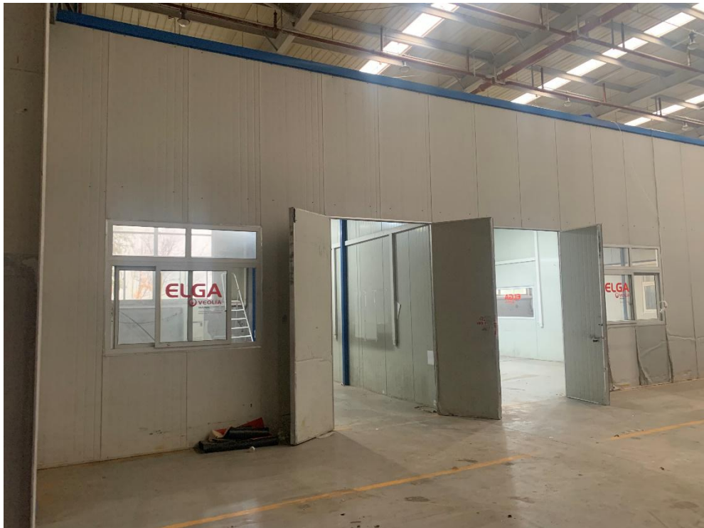
附图 8 现有厂区设备已拆除照片
